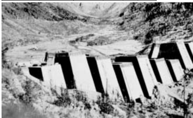
LA DIGA DI MALGA BISSINA IN COSTRUZIONE (1956)
